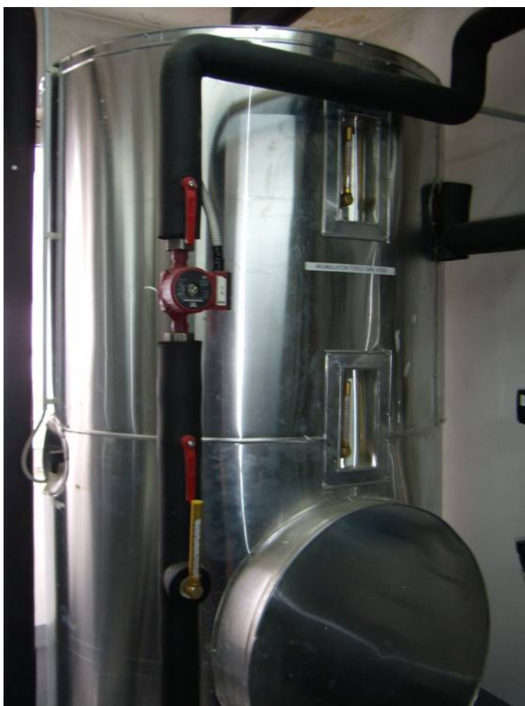
Slika 19: Hranilnik tople sanitarne vode V = 1.500 lit.
