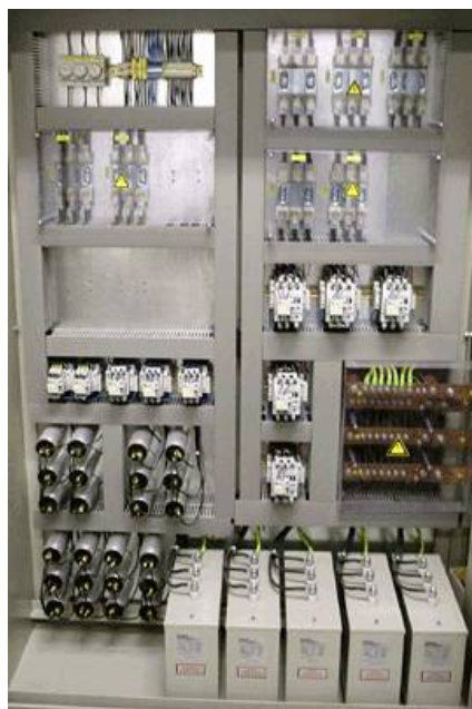
Slika 28: Kompenzator jalove energije
