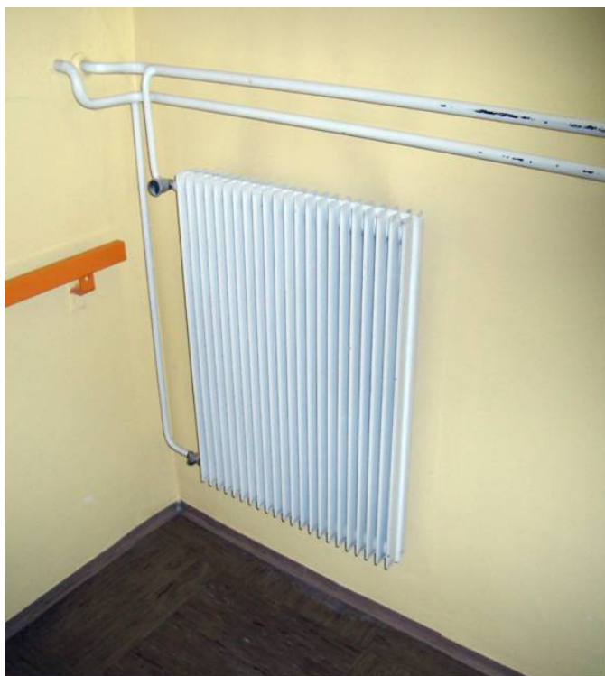
Slika 18: Radiator z navadnimi ventili
