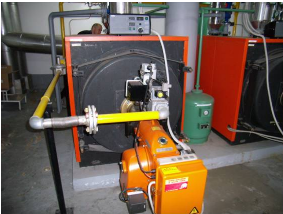
Slika 15: Dva kotla na zemeljski plin za ogrevanje
