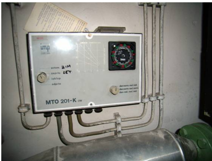
Slika 17: Zastarela regulacija v toplotni podpostaji
