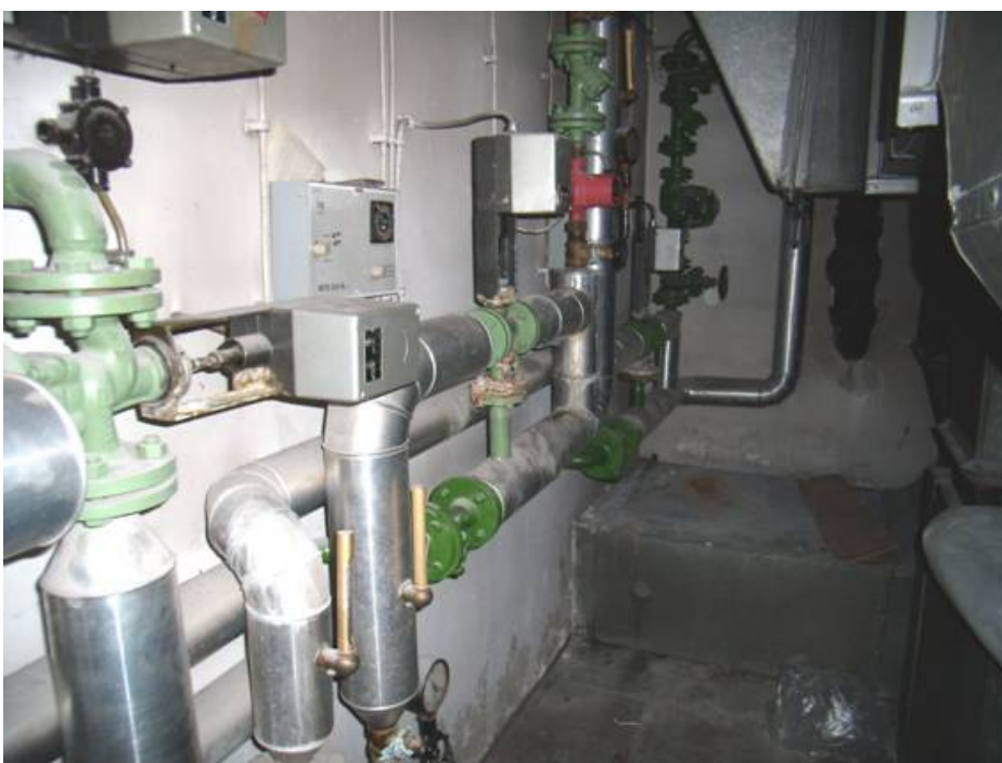
Slika 16: Toplotna podpostaja za objekt B - dotrajana
